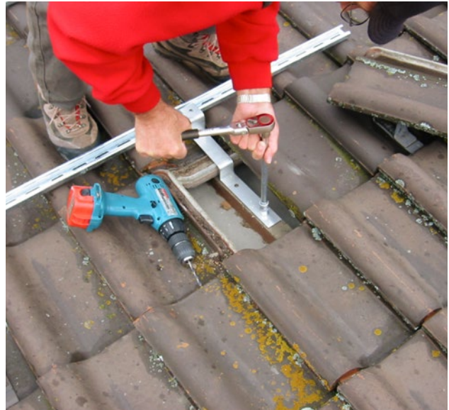
Vorbereitungsarbeiten für Aufdachinstallation
