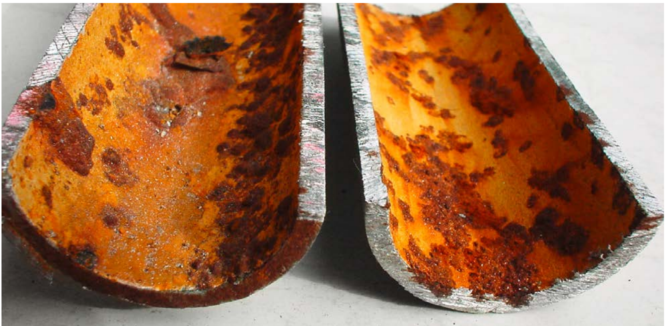
Korrosion in Heizungsrohren
